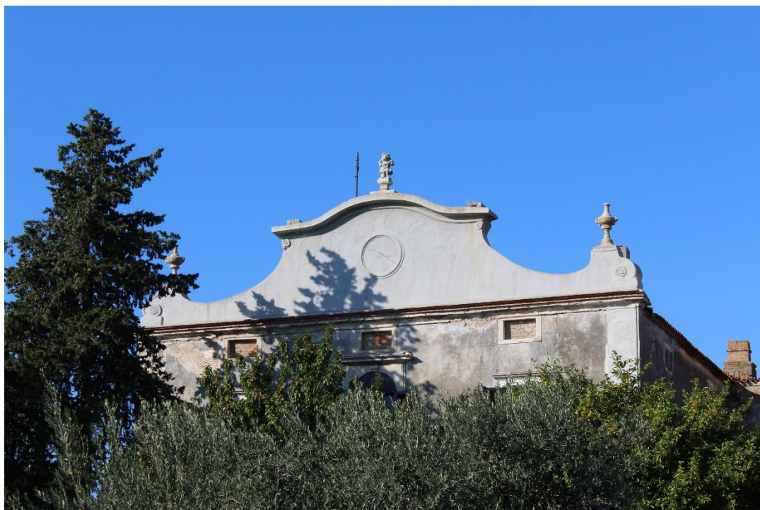
Slika 10. Glavna palača kompleksa danas, (foto: R. Kmet)
