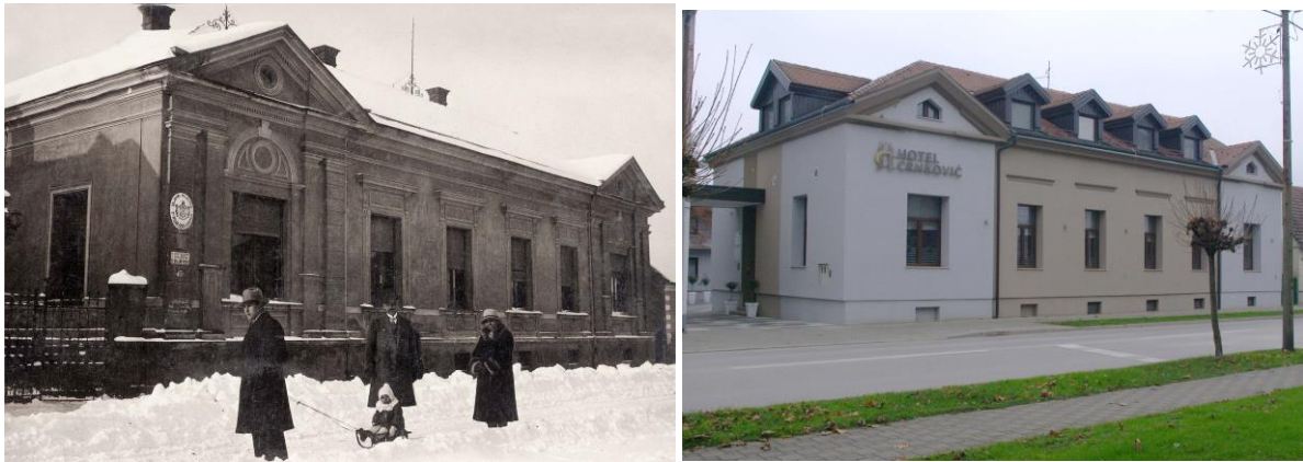
Slika 119 (lijevo): Kuća javnog bilježnika, arhitekt Martin Pilar, snimljeno 1928/9.
