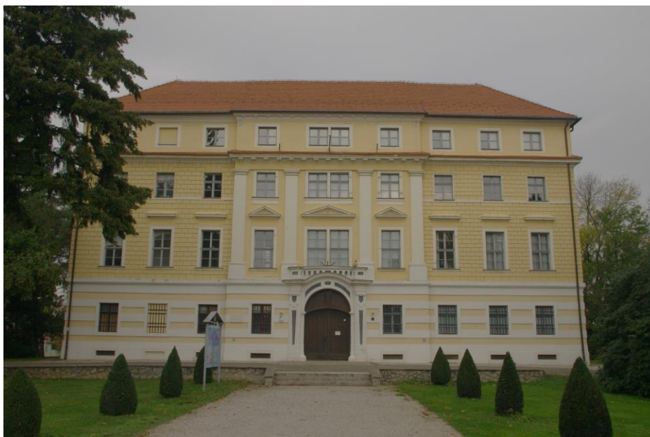
Slika 53: Dvorac Batthyány, fasada pročelja
