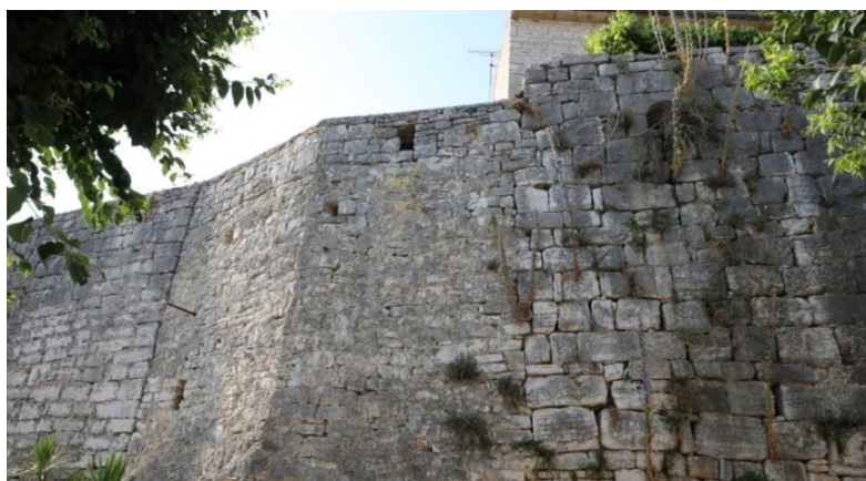
Slika 19. Zidine ispred južnog pročelja Kapetanove kuće sa strijelnicom okruglog otvora, snimila: Irena Radoslav 2021.
