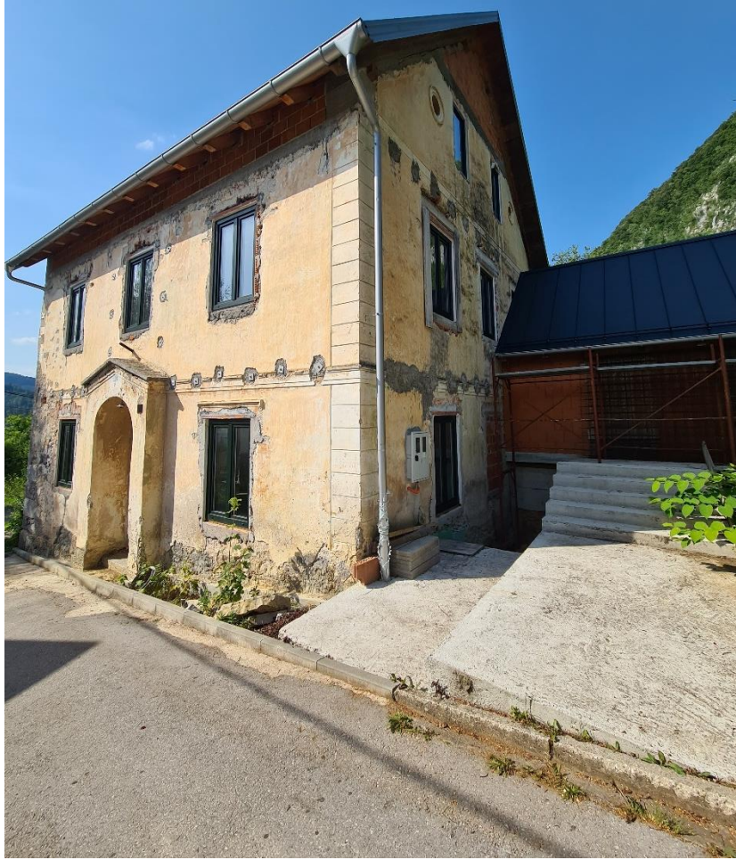
Slika 46. Područna škola u Podstenama, pogled na prednji i bočni dio (Foto: Katarina Tušek)
