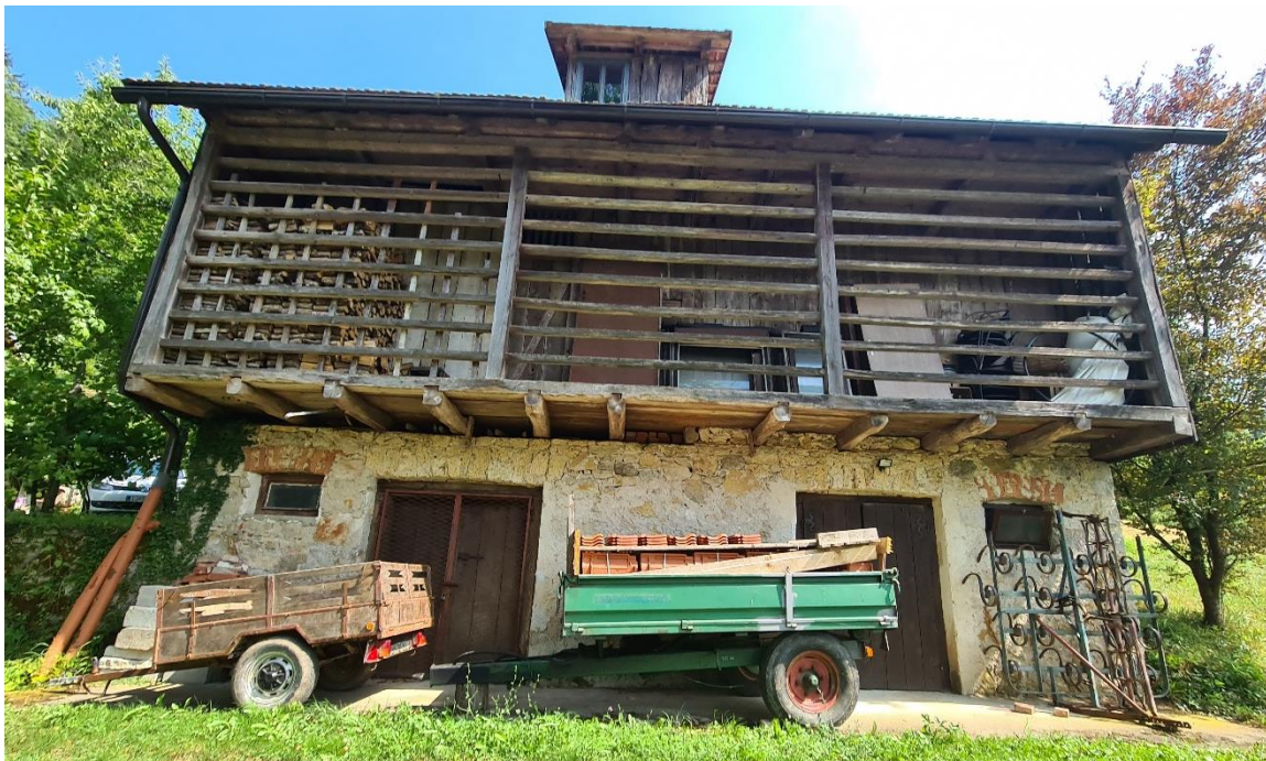
Slika 27. Prislonjeni kozovc sa stražnje strane šajara - Pr Zibarjevih u Dolušu (Foto: Katarina Tušek)
