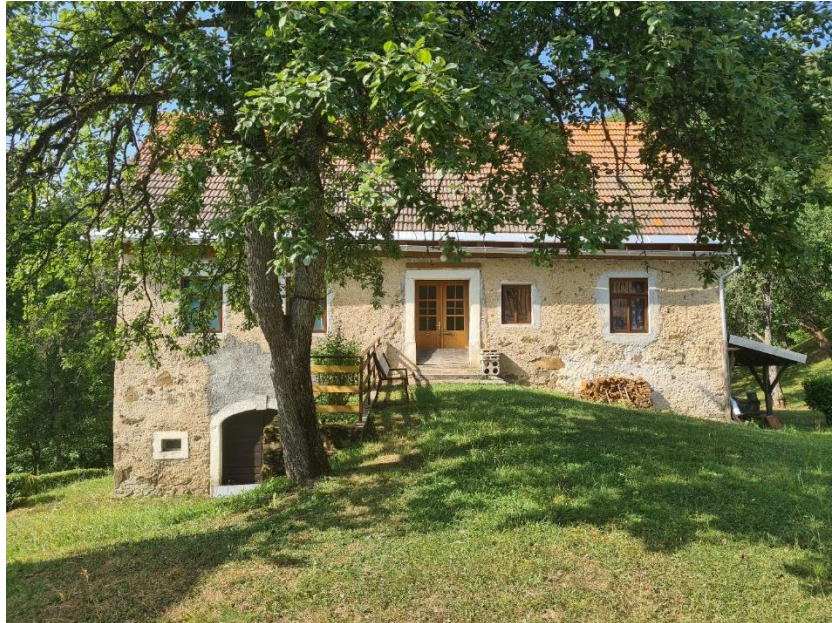
Slika 18. Kuća na adresi broj 4 u Smišljaku, pogled srijeda (Foto: Katarina Tušek)
