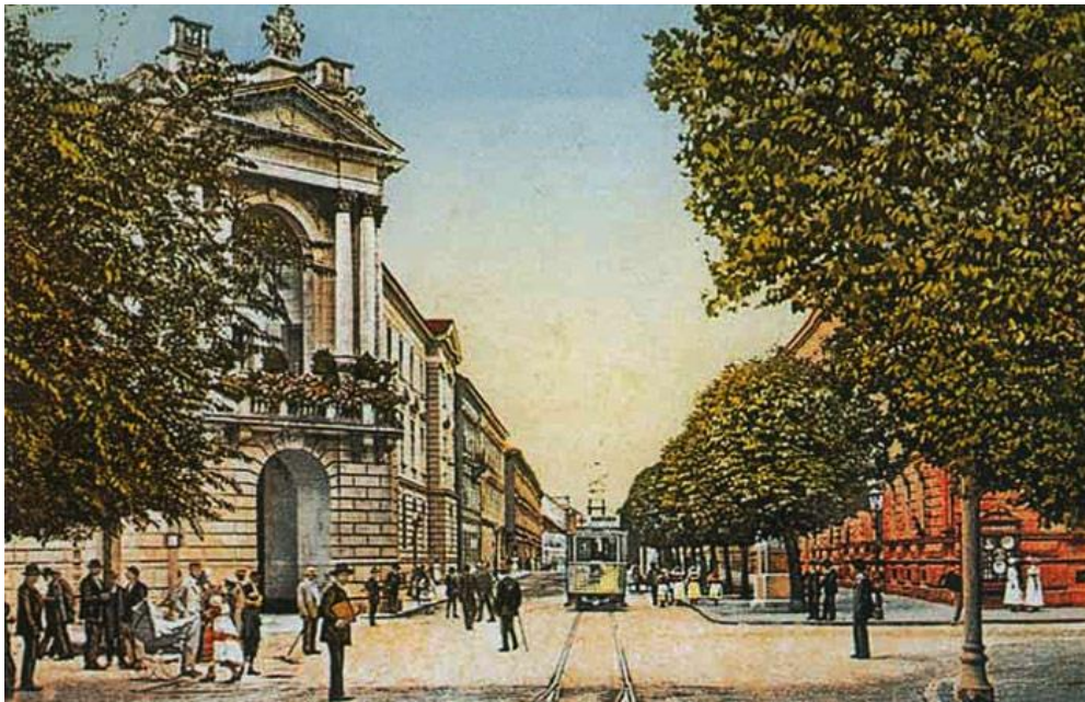
Slika 4 - pogled na pročelje palače Vranyczany-Dobrinović
