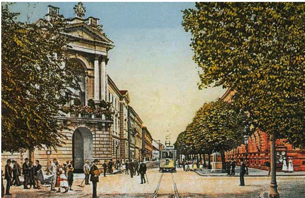
Slika 4 - pogled na pročelje palače Vranyczany-Dobrinović
