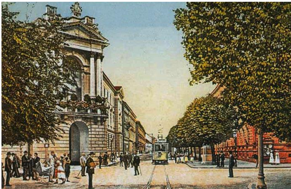
Slika 4 - pogled na pročelje palače Vranyczany-Dobrinović
