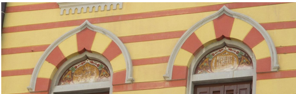
Slika 20: Detalj pročelja, lunete drugoga kata, Turska kuća, 1906. g.
