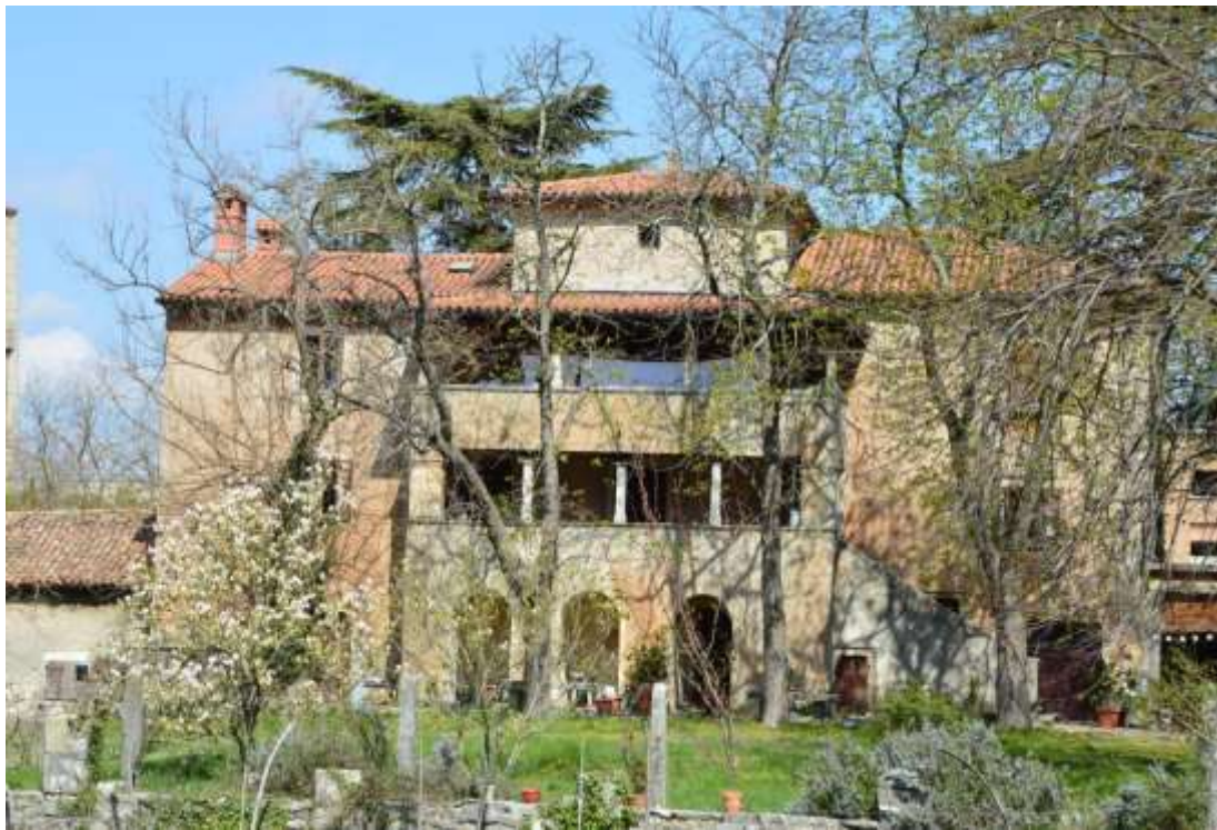
Slike 54., 55. i 56. Labin, ladanjska kuća Scampicchio, fotografija iz ptičje perspektive, fotografija ostataka ulaznog portala i fotografija južnog pročelja (foto: K. Rabar, 2022.)
