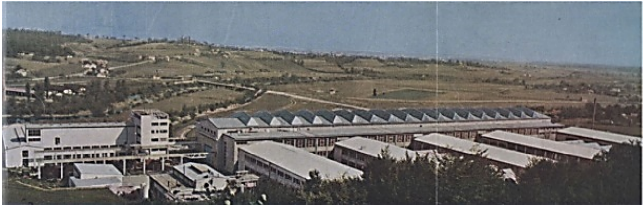
Slika 18. Jugoturbina u prošlosti
