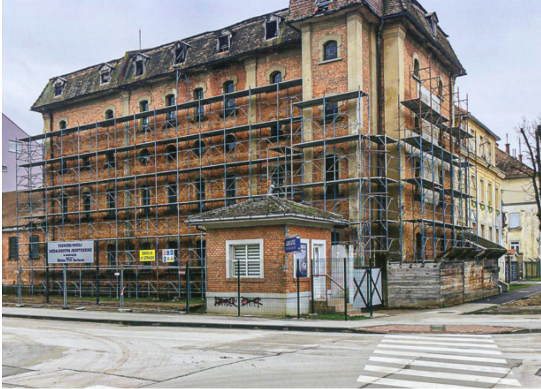
Slika 33. Početak obnove poslovne zgrade bivšeg Mustada , Rakovac, Karlovac, 2020.
