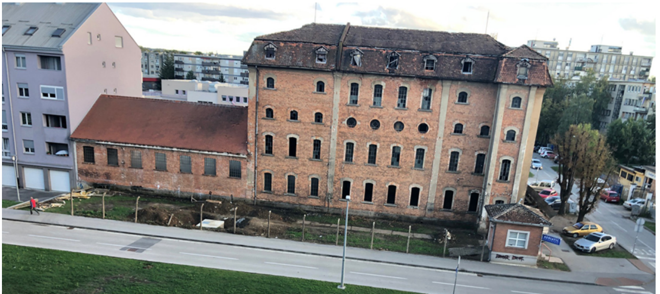
Slika 32. Stanje poslovne zgrade bivšeg Mustada prije obnove
