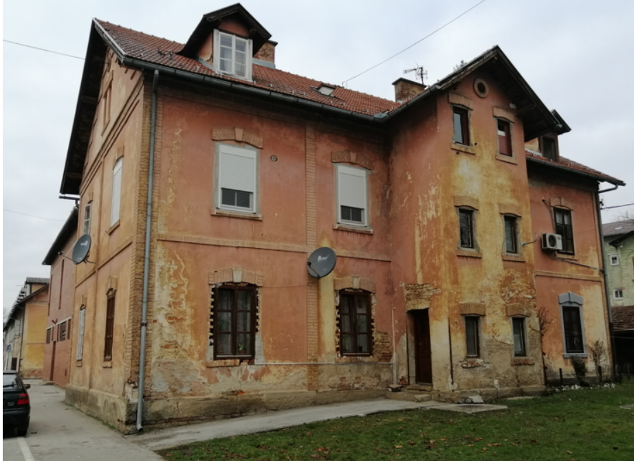
Slika 26. Stambena zgrada u naselju Kasar , 2022.
