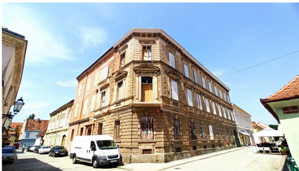
Zgrada Srpske pravoslavne općine u Radićevoj ulici 14, 1882. (29. 6. 2022.)
