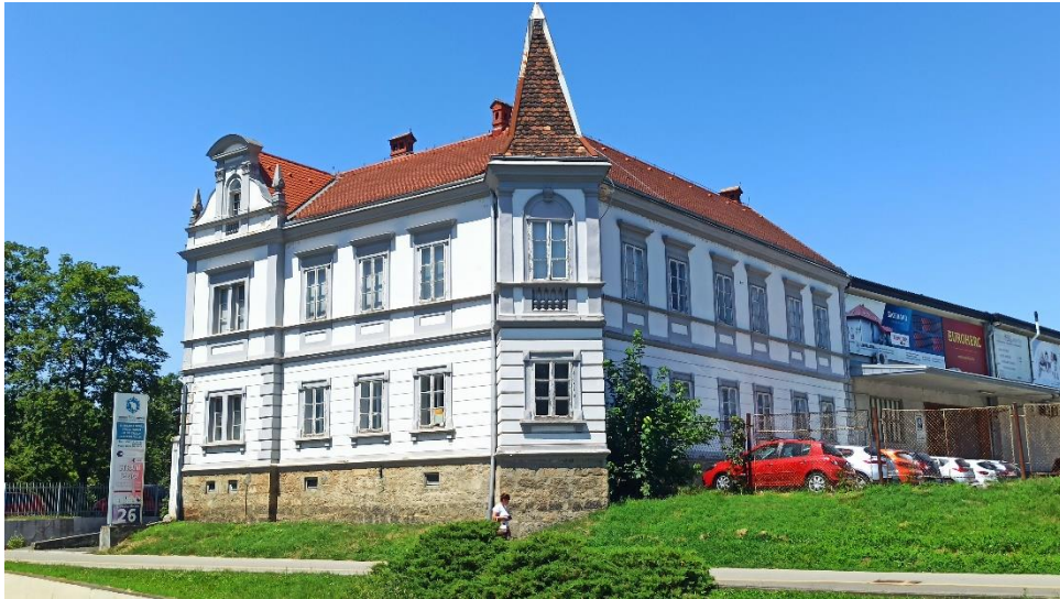
Upravna zgrada Tvornice Ignac Jellenc, 1908., stanje danas (1. 7. 2022.)
