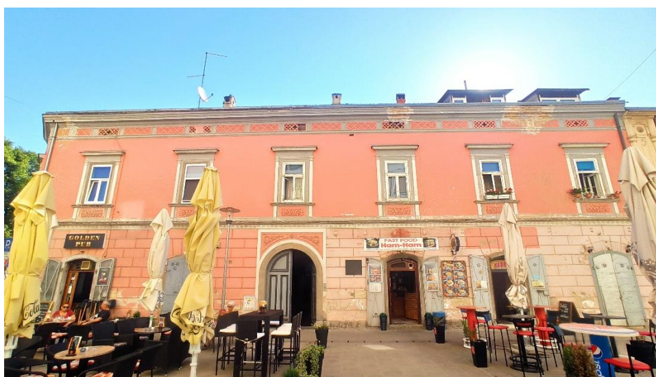
Uglovnica u Šebetićevoj ulici 4 (Kuća Bunete), 1880ih
