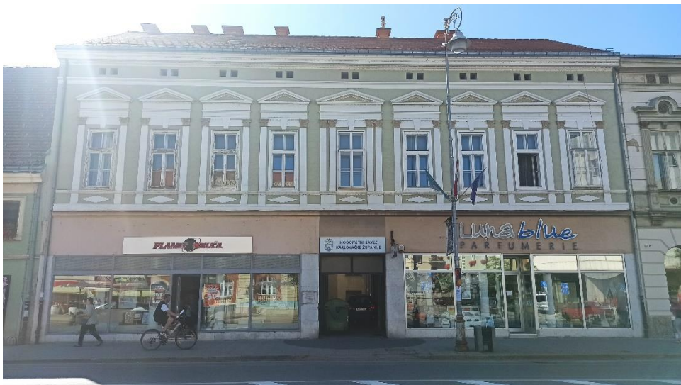
Kuća Banjanin na Zrinskom trgu 5, 1880ih (1. 7. 2022.)
