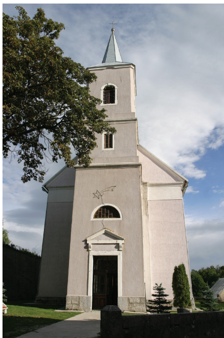
Slika 4. Fužine, zvonik župne crkve sv. Antuna Padovanskog istaknut u osi pročelja, foto: Damir Krizmanić
