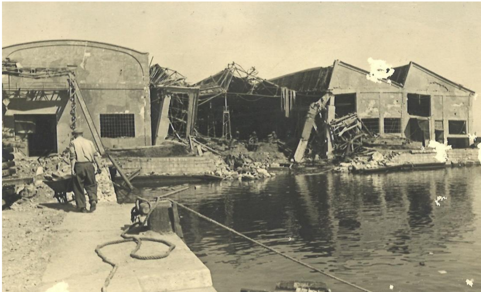
Slika 6. Uništena postrojenja tvornice Torpedo
