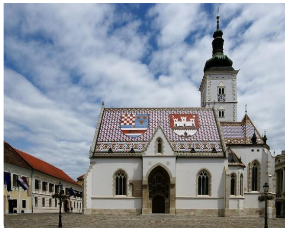
Slika 2. Crkva sv. Marka, južno pročelje (Izvor: https://hr.wikipedia.org/wiki/Crkva_sv._Marka_u_Zagrebu )
