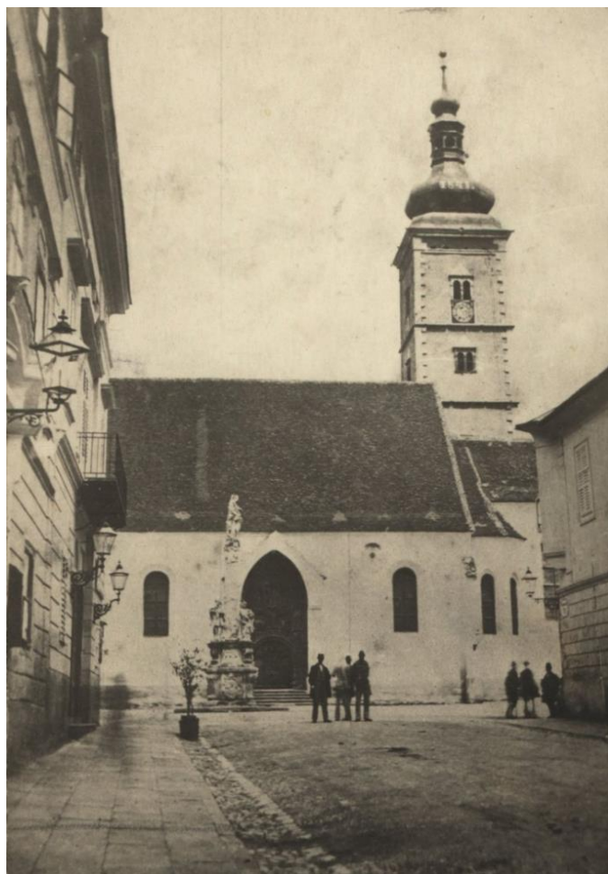
Slika 10. Crkva sv. Marka 1862. godine, prije Schmidtove restauracije (Izvor: https://ika.hkm.hr/novosti/zagrebacka-nadbiskupija-zupna-crkva-sv-marka-na-zagrebackom-gornjem-gradu/ )
