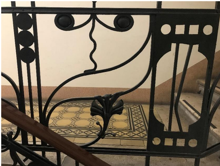
Slika 27. Stubišna ograda (Giuseppe Farkas, Uglovnica Hering II , 1912., križanje Ulice Ivana Zajca i Uljarske ulice), foto Luka Štimac.
