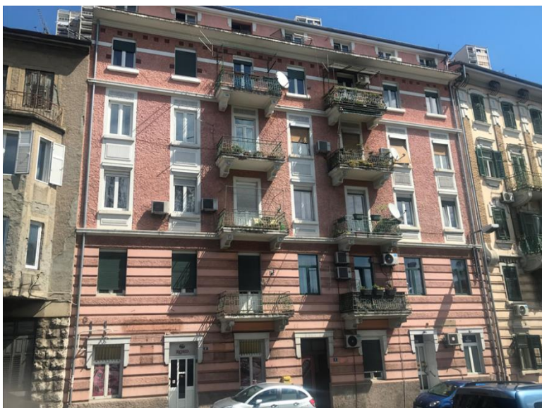
Slika 111. Glavno, ulično pročelje (Giuseppe Farkas, Kuća Wotzelka-Schwarz , 1913., Osječka 6), foto Luka Štimac.
