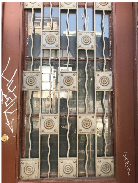
Slika 93. Rešetke ulaznih vrata (Sandor Mezey, Zgrada Mađarskih kraljevskih državnih željeznica , 1911. Žabica/Krešimirova Ulica), foto Luka Štimac.
