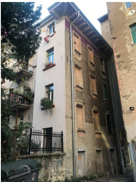
Slika 63. Pogled na sjeverno i istočno pročelje kuće (Venceslao Celligoi, Kuća Frank-Kiss , 1910., Ulica 1. maja 32), foto Luka Štimac.
