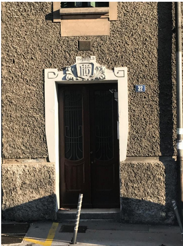
Slika 59. Detalj pročelja s ulaznim portalom (Venceslao Celligoi, Kuća Frank-Kiss , 1910., Ulica 1. maja 32), foto Luka Štimac.
