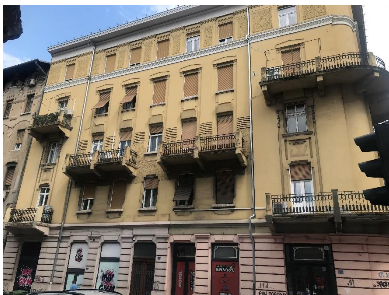
Slika 77. Glavno, južno pročelje kuće (Emilio Ambrosini, Kuća Tomašić , 1912., Fiorella La Guardia 8, 8A, 8B/Ulica Blaža Polića 7), foto: Luka Štimac.
