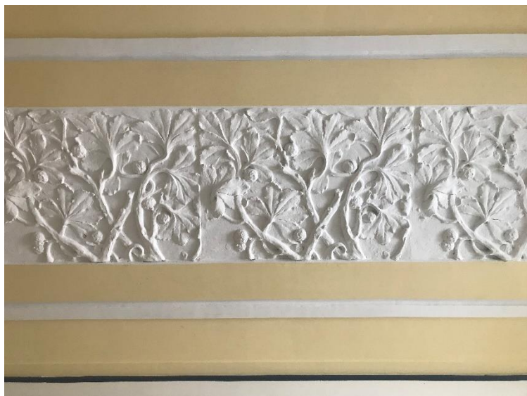
Slika 24. Detalj dekoracije na stropu ulazne veže (Giuseppe Farkas, Kuća Hering-Székely , 1909., Laginjina ulica 17), foto Luka Štimac.
