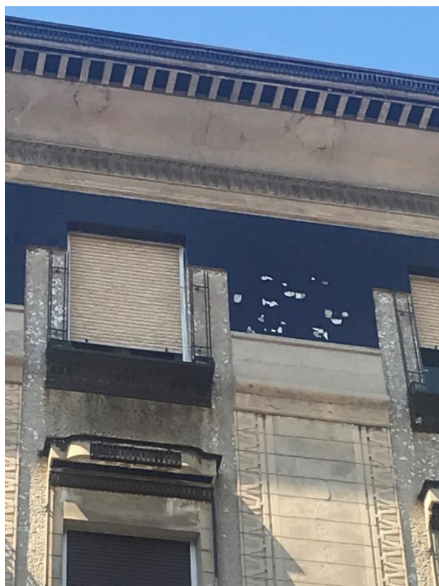
Slika 36. Detalj gornjeg dijela pročelja (Giuseppe Farkas, Kuća Hering-Székely, 1909., Laginjina ulica 17), foto Luka Štimac.
