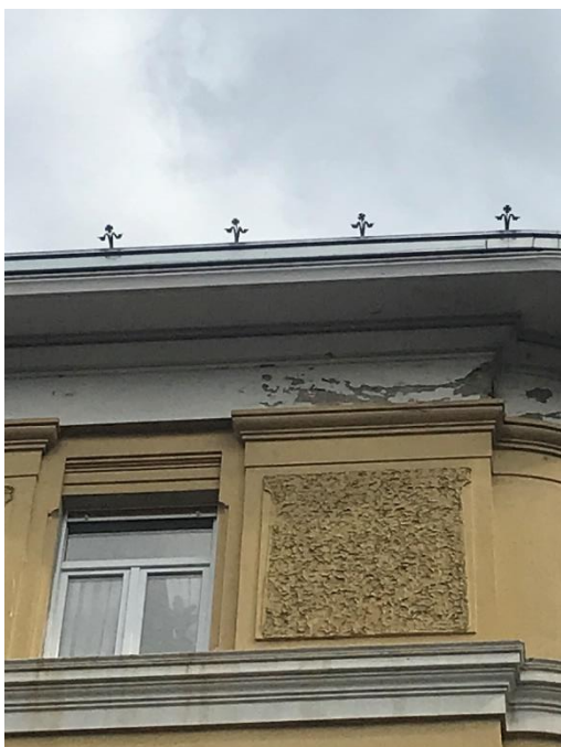
Slika 78. Detalj gornje zone glavnog, južnog pročelja kuće (Emilio Ambrosini, Kuća Tomašić , 1912., Fiorella La Guardije 8, 8A, 8B/Ulica Blaža Polića 7), foto: Luka Štimac.
