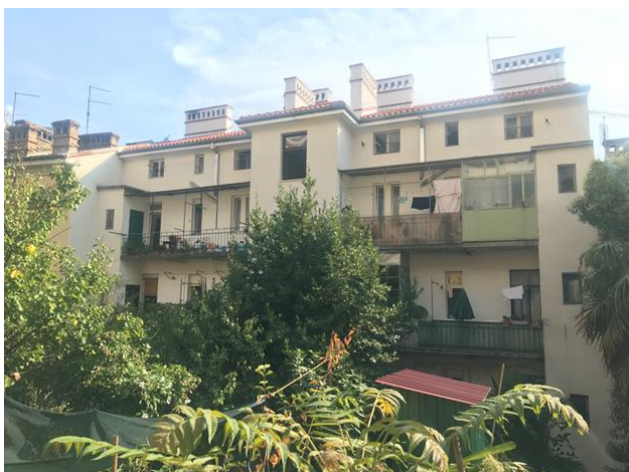
Slika 115. Dvorišno pročelje (Giuseppe Farkas, Kuća Wotzelka-Schwarz , 1913., Osječka 6), foto Luka Štimac.
