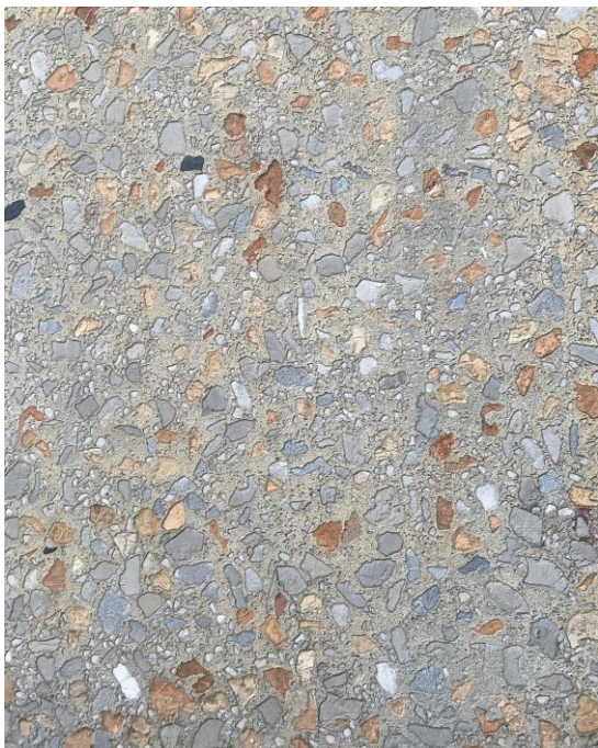
Slika 34. Detalj betonskog polja na zidu uličnog pročelja (Giuseppe Farkas, Kuća Hering-Székely , 1909., Laginjina ulica 17), foto Luka Štimac.
