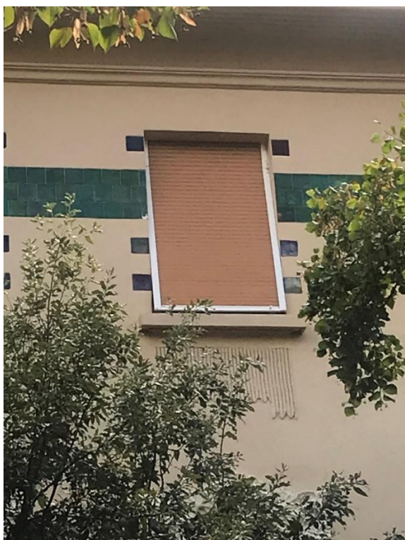
Slika 94. Detalj sjevernog pročelja s pločicama u razini trećeg kata (nepoznati autor, kuća/vila Hodak , 1912. Šetalište Ivana Gorana Kovačića 14), foto Luka Štimac
