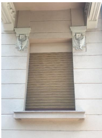
Slika 87. Detalj sjevernog pročelja u razini prvog kata (nepoznati autor, kuća/vila Hodak , 1912. Šetalište Ivana Gorana Kovačića 14), foto Luka Štimac.
