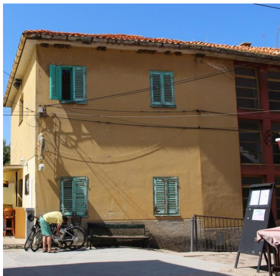
Slika 6.: Današnja zgrada na mjestu Vitezićeva doma
