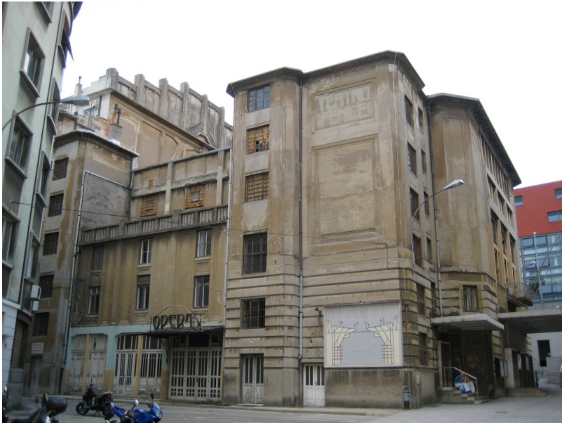
Slika 51. Teatro Fenice, južno i istočno pročelje
