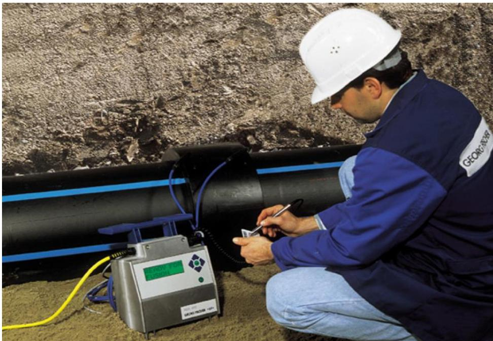
Slika 4.1. Elektrofuzijsko zavarivanje[8]
