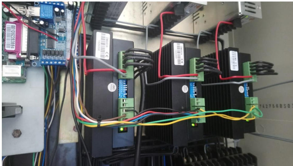
Slika 5.7. Driveri za pogon motora
