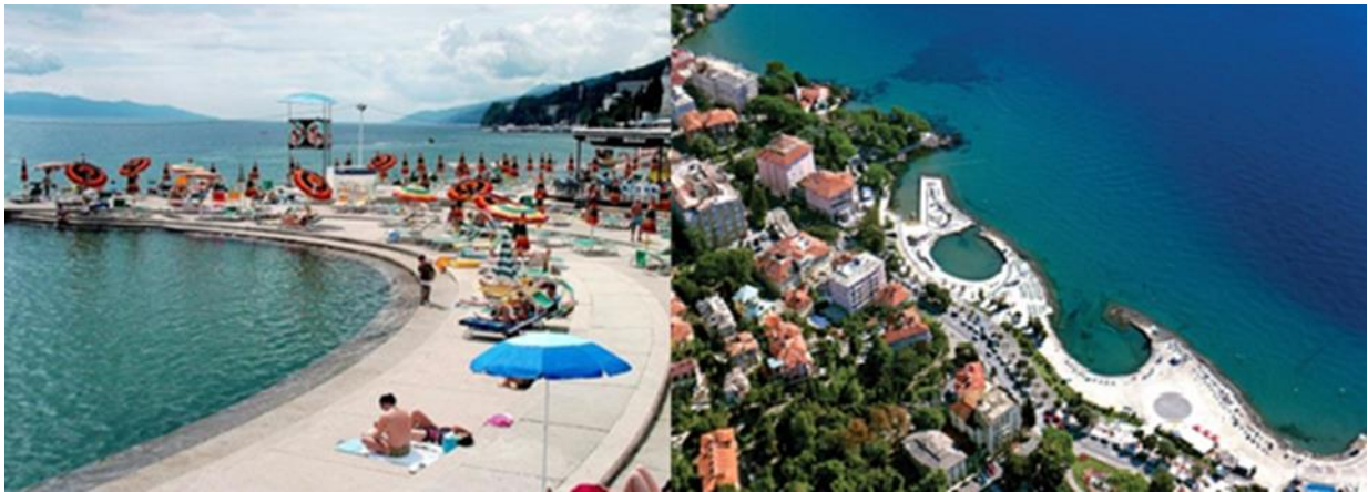
Slika 10. Primjer betonske plaže u središtu grada Opatije
