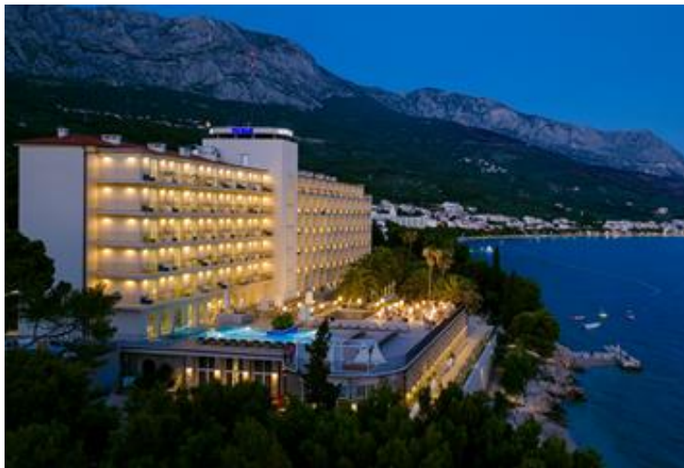
Slike 22. i 23. Hotel Jadran prije i poslije rekonstrukcije i revitalizacije
