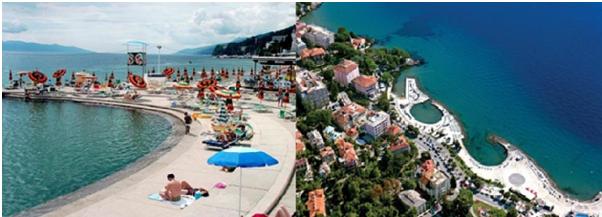
Slika 10. Primjer betonske plaže u središtu grada Opatije
