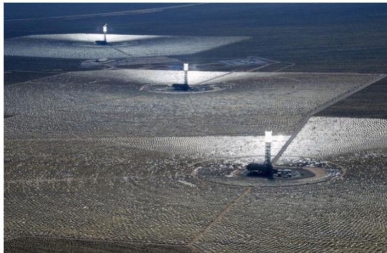
Sl.3.14. solarna termoelektrana Ivanpah s tri tornja s prihvatnikom i poljima heliostata [20]
