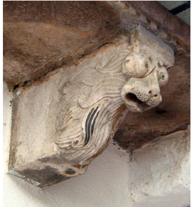
13. Senj, konzola lavljeg dvora, (foto: D. Krizmanić)
