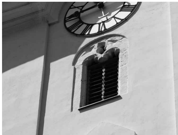
8. Kloštar Ivanić, crkva sv. Marije, zvonik, šesti kat, istočno pročelje, kasnogotičko mrežište (foto: M. Cepetić Rogić) / Kloštar Ivanić, church of St Mary, belfry, sixth floor, east front, late Gothic tracery (photo: M. Cepetić Rogić)
