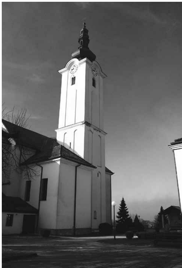
3. Kloštar Ivanić, crkva sv. Marije, zvonik, pogled sa sjeveroistoka (foto: M. Cepetić Rogić) / Kloštar Ivanić, church of St Mary, belfry, view from northeast (photo: M. Cepetić Rogić)
