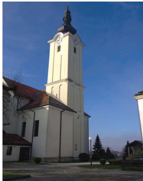
Slika 3. Crkva sv. Marije, pogled sa sjeveroistoka.
