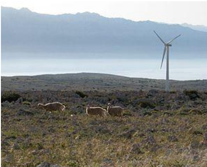
Slika 13. Vjetroelektrana Ravne na Pagu [18].
