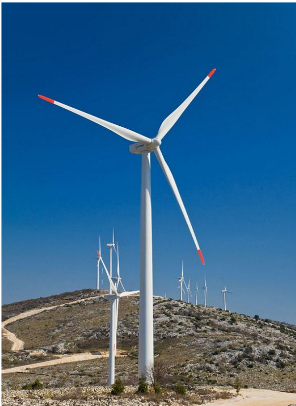
Slika 12. Vjetroagregat s vodoravnom osi (Šibenik) [18].
