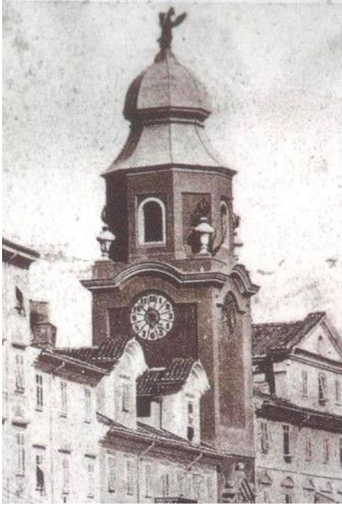
Fig. 15. Torre civica intorno al 1865
