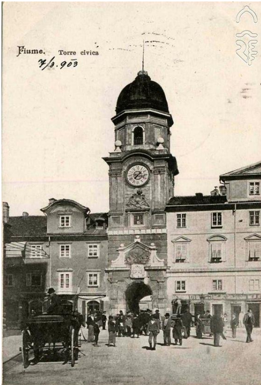
Fig. 17. Torre civica prima del 1906
