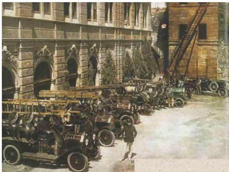
Fig. 10. Nell'edificio scolastico di Via Ciotta avevano sede tra il 1888 e il 1929 i pompieri volontari
