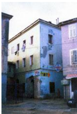
Slika 2.: Zgrada prve Hrvatske čitaonice (desno krilo stare Pomorske škole u Malom Lošinjju) 72
