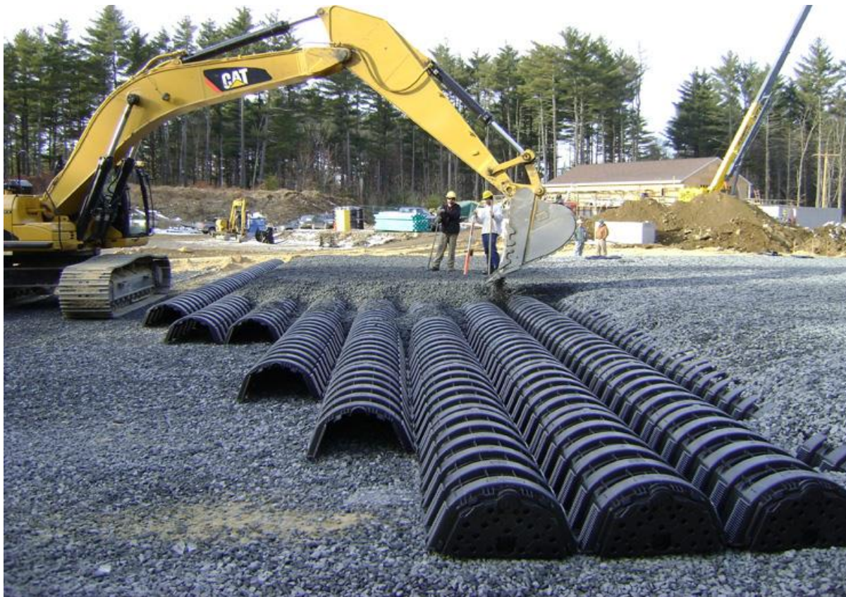
Slika 7. Gradnja podzemnog ispusta [17].
