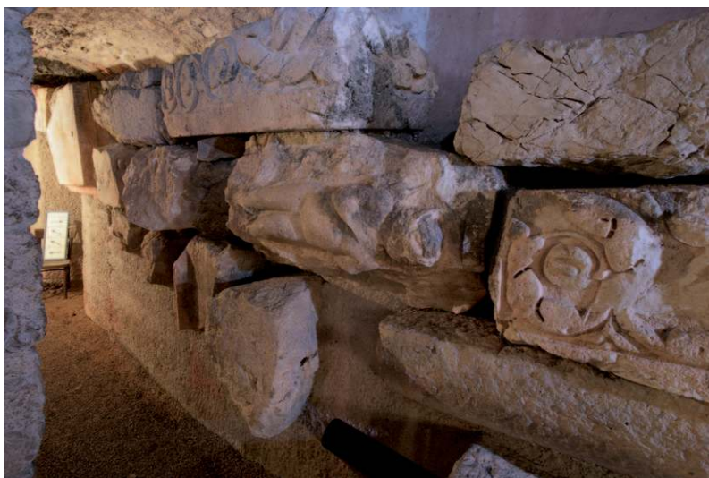
Grad Krk. Supstrukcije zapadnih gradskih zidina, dobrim se dijelom sastoje od sekundarno korištene građe reprezentativnih antičkih građevina (foto D. K.).
