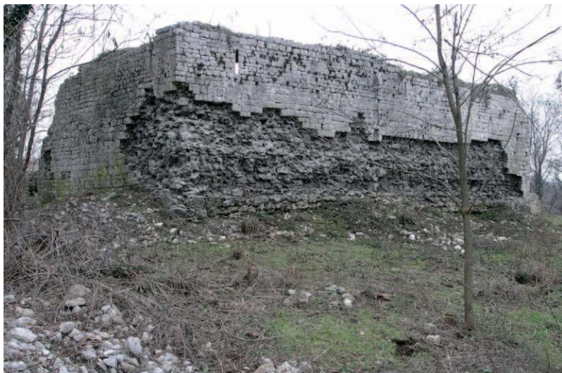
Ostatci frankopanskog kaštela Gradec nedaleko od Vrbnika na Krku (foto D. K.)
