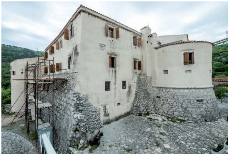
Bakarski kaštel (foto P. P.)
