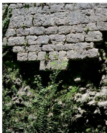
Gradec, kvadri lica zida koji nedostaju sekundarno su korišteni za gradnju kuća u zaselku Paprata (foto D. K.). Detalj (desno) (foto D. B.)
