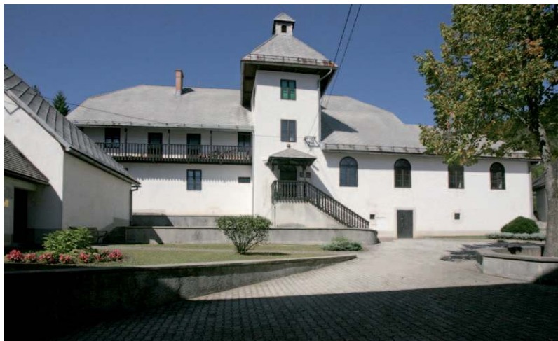
Čabar, na mjestu nekadašnjeg dvora Zrinskih danas je sjedište uprave Grada Čabra (foto D. K.)
