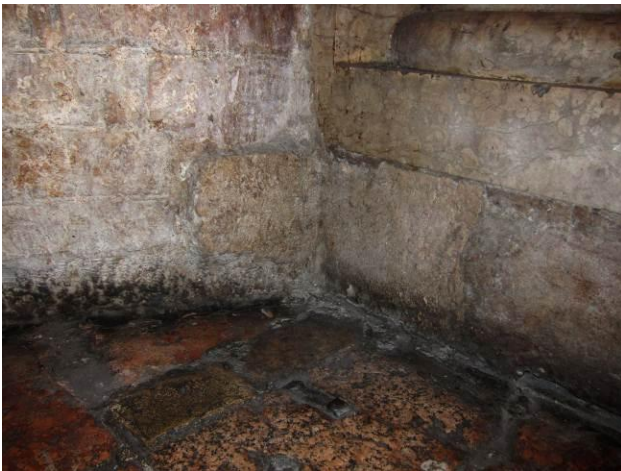
Fig. 13 Parma, Battistero, interno, particolare della pietra angolare di raccordo con la nicchia del plinto dello stipite sinistro del Portale della Presentazione al Tempio.
