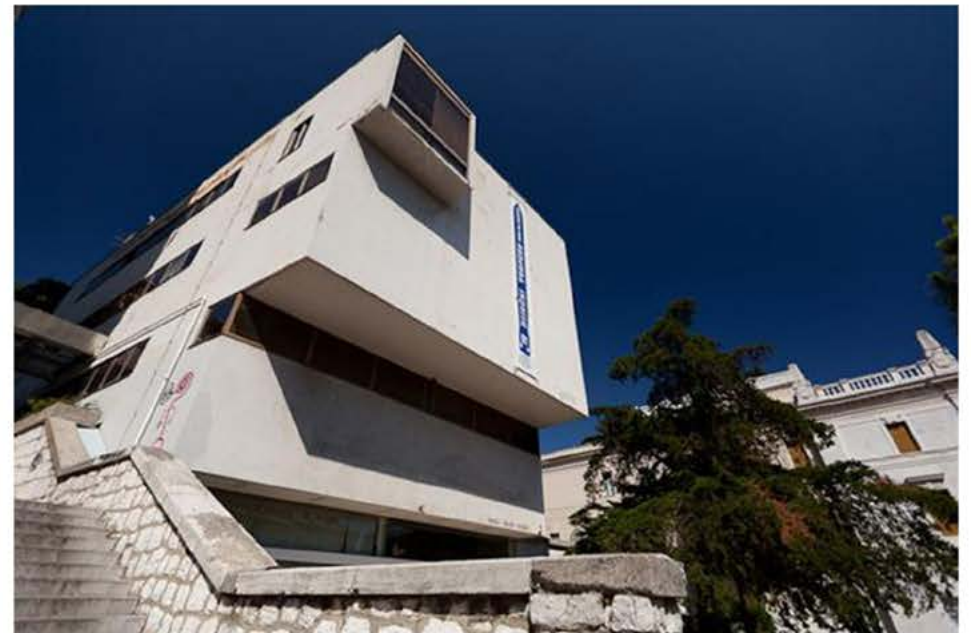
Muzeja grada Rijeke, pročelje ( http://www.visitrijeka.hr/Sto_vidjeti/Muzeji_i_zbirke/Muzej_grada_Rijeke , 3.12.2014.)
