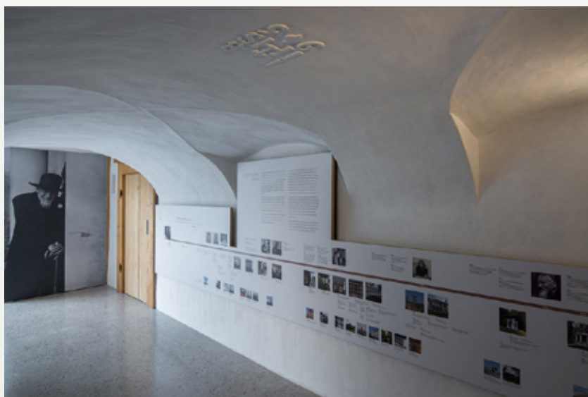
Plečnikova kuća, veža, stanje nakon obnove
