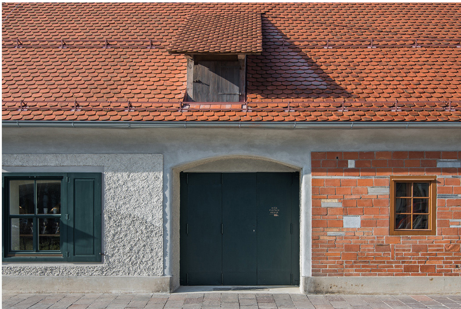
Plečnikova kuća, pročelje, stanje nakon obnove
