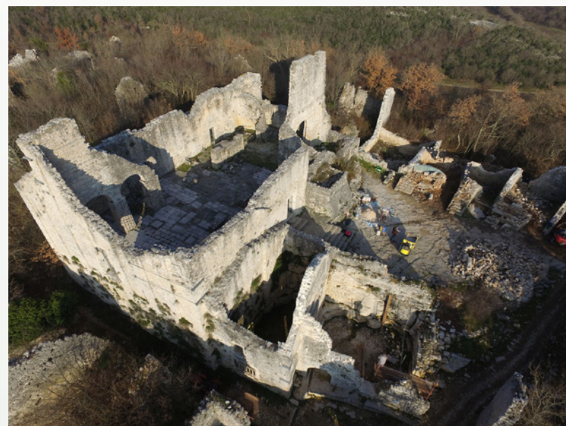
Dvigrad - crkva sv. Sofije i gradski trg tijekom obnove 2016., foto B. Orbanić
