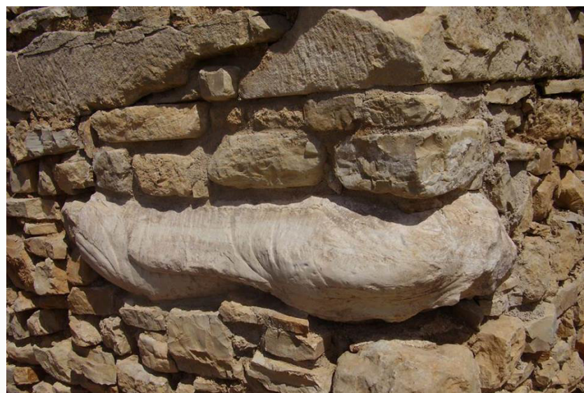
Primjer korištenja spolija kao sekundarnog građevinskog materijala, fortifikacijski zid Aserije (TOMIĆ, 2010, 362)
