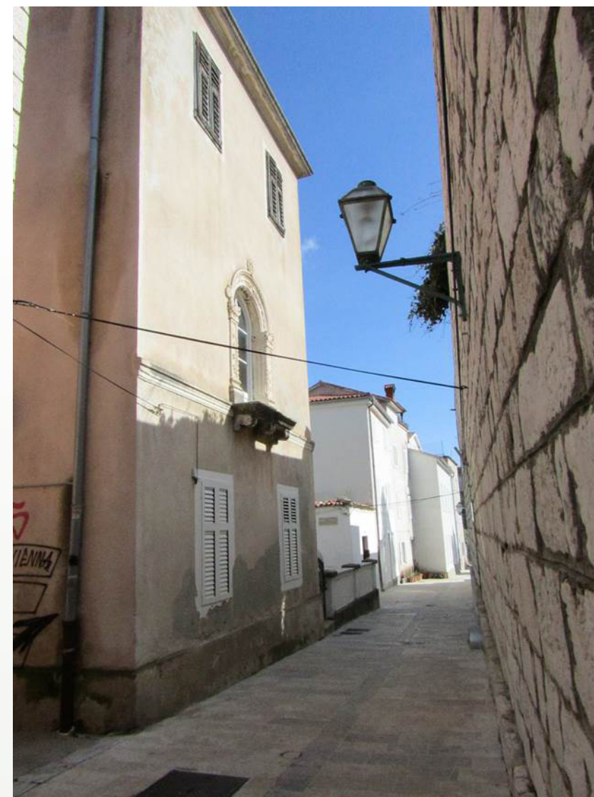
Sadašnji izgled kuće na Gornjoj ulici preko puta gradske knjižnice, foto: Natalia Beg
