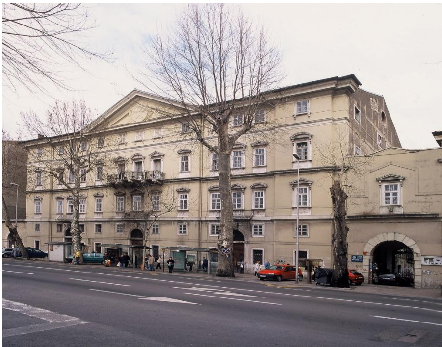
Slika 3. Upravna zgrada bivše rafinerije Šećera
