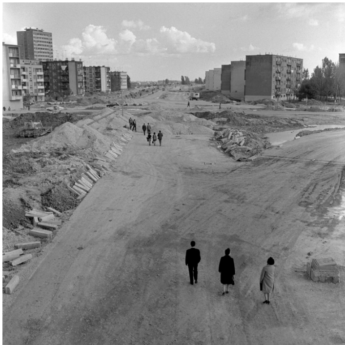
7. Travno 1974. godine , na početku izgradnje naselja.
