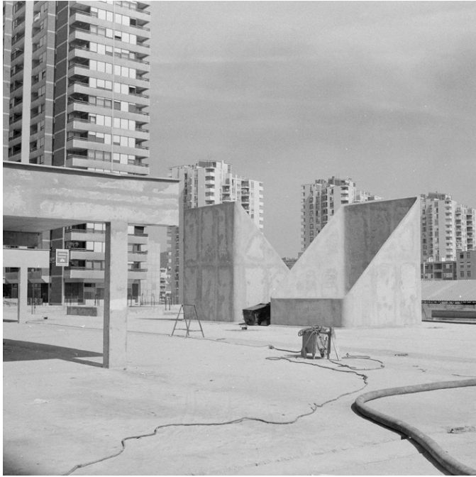
8. Pogled na otvore za ventilaciju podzemnih etaža, 1976. godina
