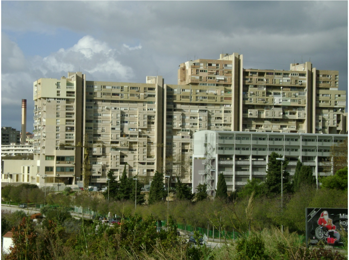
Stambena zgrada u ulici Ruđera Boškovića, „Krstarica“.
