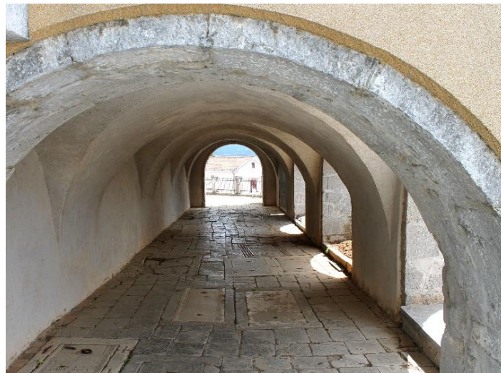
Slika 14. Supstrukcije ispod južnog broda, crkva sv. Jelene, Kastav
