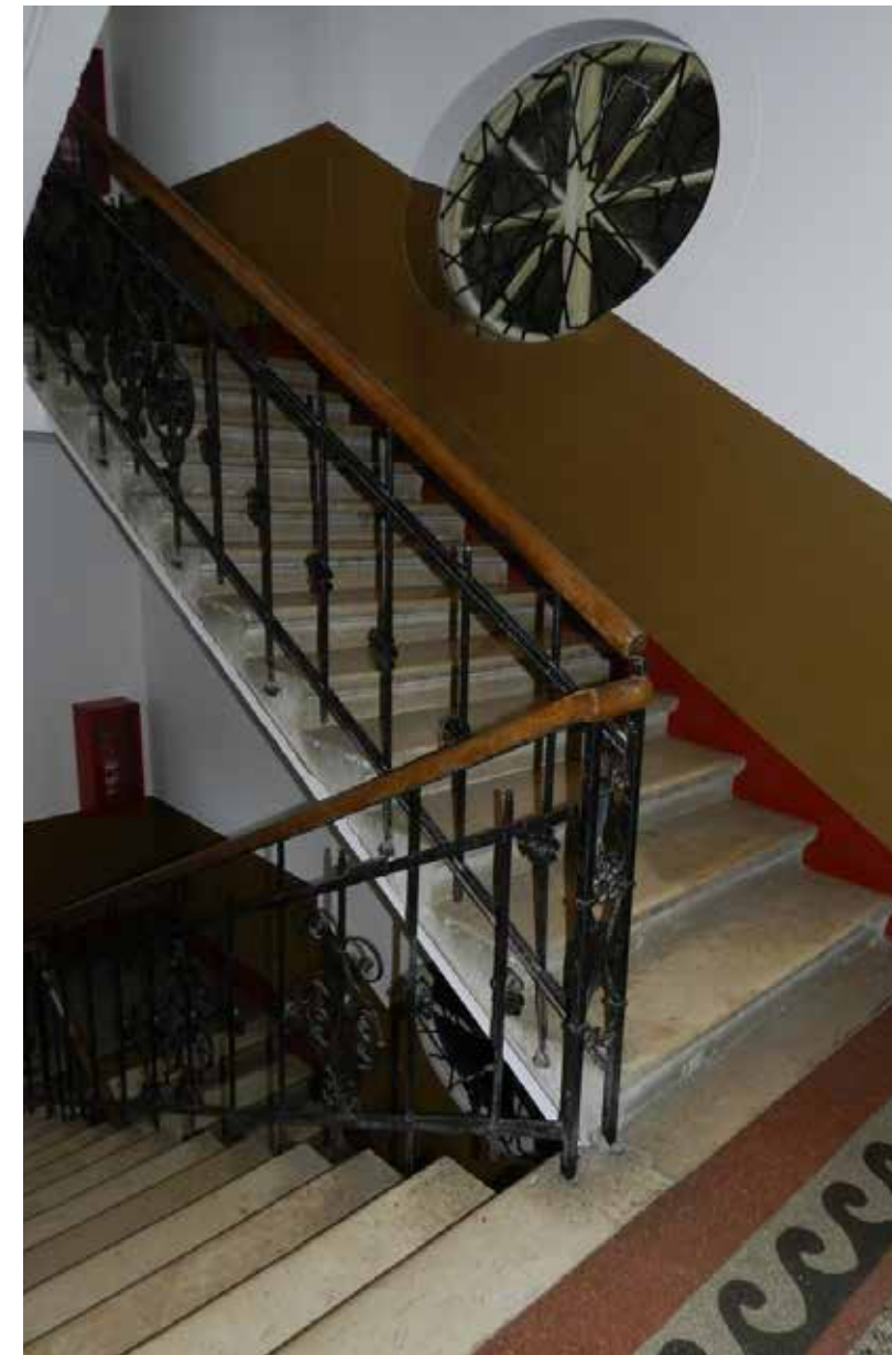
7 „Turska kuća“, Rijeka, stubište
