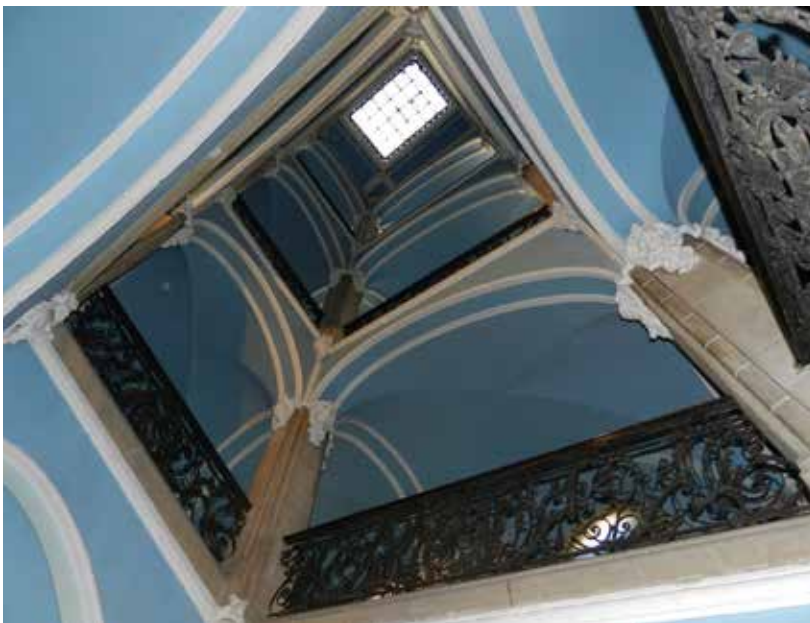
5 Palača Ploech, Rijeka, stubište
