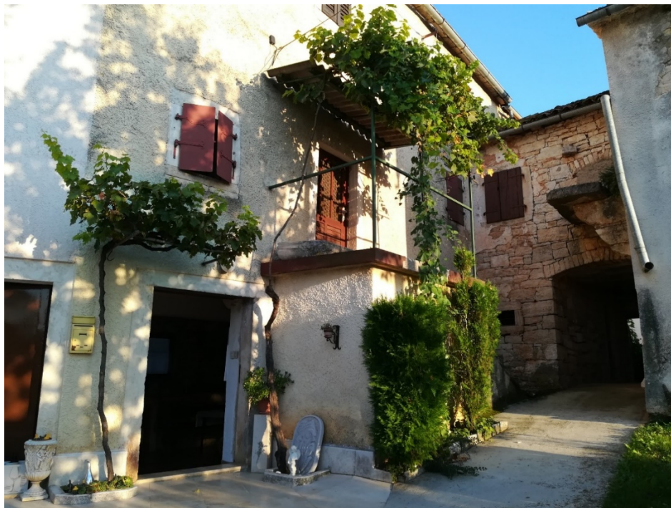
Sl. 21. Pročelje kuće građene na zapadnom potezu zidina s ulazom u konobu sa zazidanim nekadašnjim javnim prolazom
