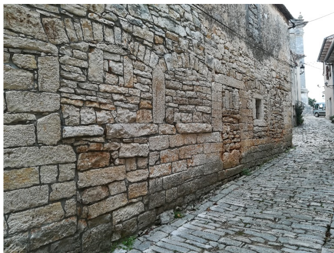
Sl. 6. Gradska loža sa zazidanim polukružnim otvorima, 2020.
