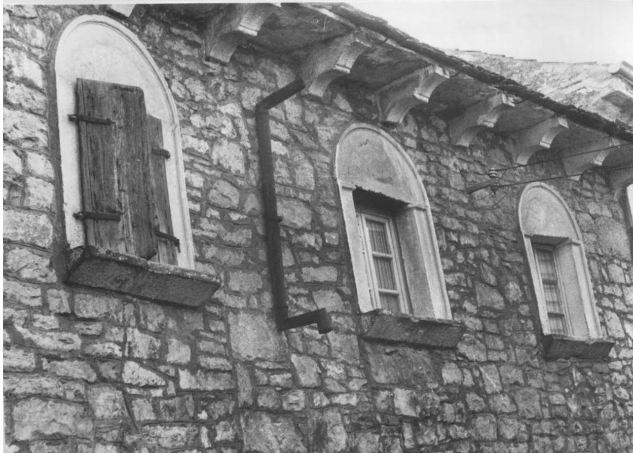
T i n j a n - kuća br. 33 - otvori u I. katu i detalj strehe f o t o - B.Ružić 1. III 74.g.
