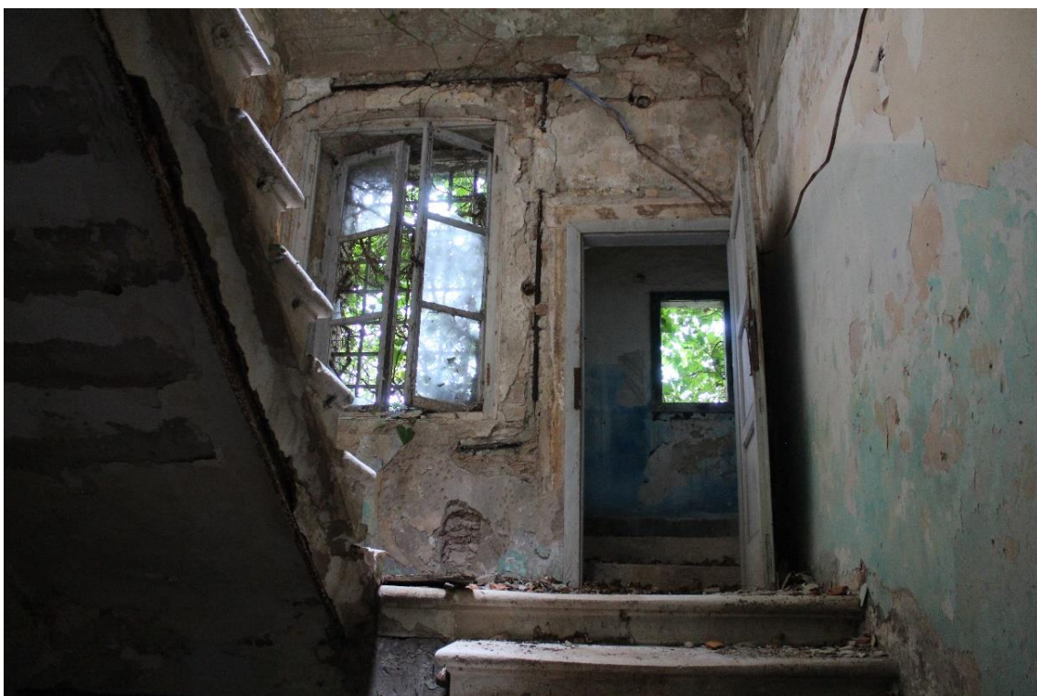
Slika 31. Stubište u nutrašnjosti palače, (foto: R. Kmet)
