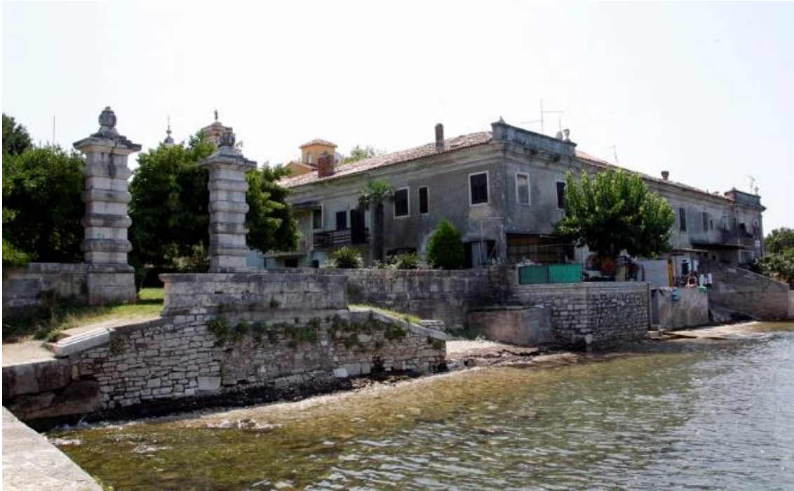
Slika 23. Zgrade zapadnog krila kompleksa s mora
