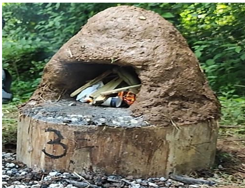
Slika 12 – Izgradnja glinene peći u školskom vrtu, treći razred učiteljice Ive Merlak iz Osnovne waldorfske škole u Rijeci
