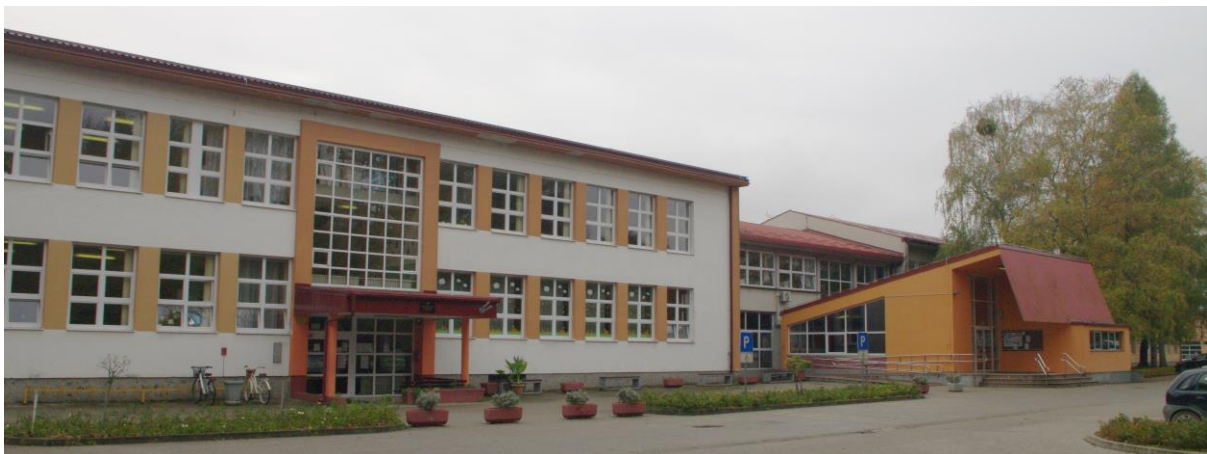
Slika 18: Školska zgrada paviljonskog tipa, najstariji dio (lijevo) građen je 1964. godine
