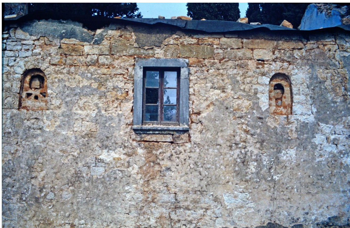
Slika 56. Južna fasada crkve sv. Lovre na groblju prije sanacije krova 1990., snimio: Ivan Matejčić
