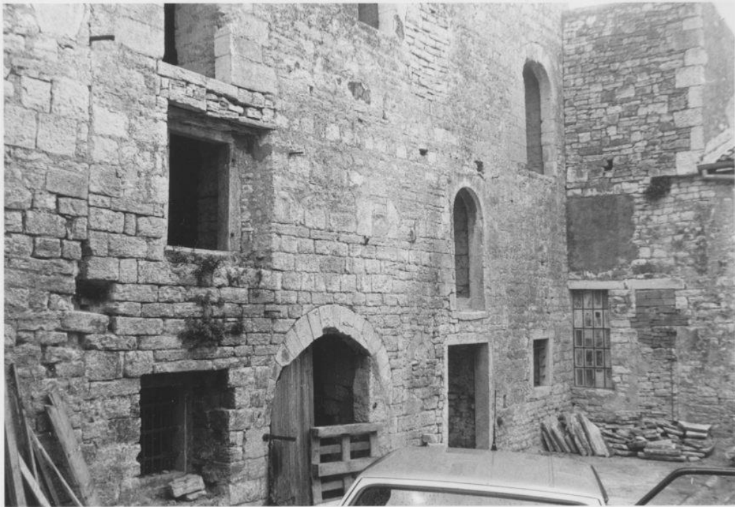
Lovreč – k.č. 55/2 Zgrada na bedemu, dvorišna fasada, donji dio u prizemlju bio sekundarno ugrađen noviji "Toš" – mlin uklopljen u toku radova adaptacije foto: D.Grigić, 15.5.1994.
