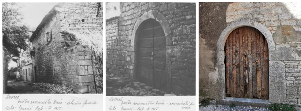
Slika 41, 42. i 43. Istočno pročelje nekadašnje škole i detalj portala nekadašnje škole, snimio: J. Vranić 1955. (Fototeka Konzervatorskog odjela u Rijeci), portal kuće na k.č. 48, snimila Irena Radoslav 2021.
