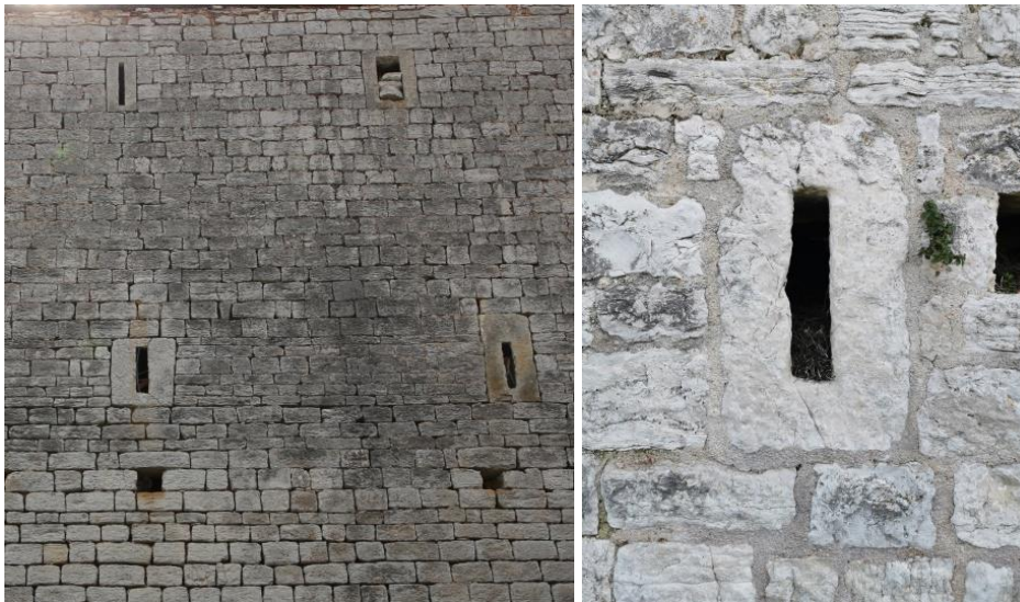
Slika 10. i 11. Strijelnice na sjevernoj kvadratnoj kuli uz Sjeverna vrata i strijelnica na Kuli-zvoniku, snimila Irena Radoslav 2021.
