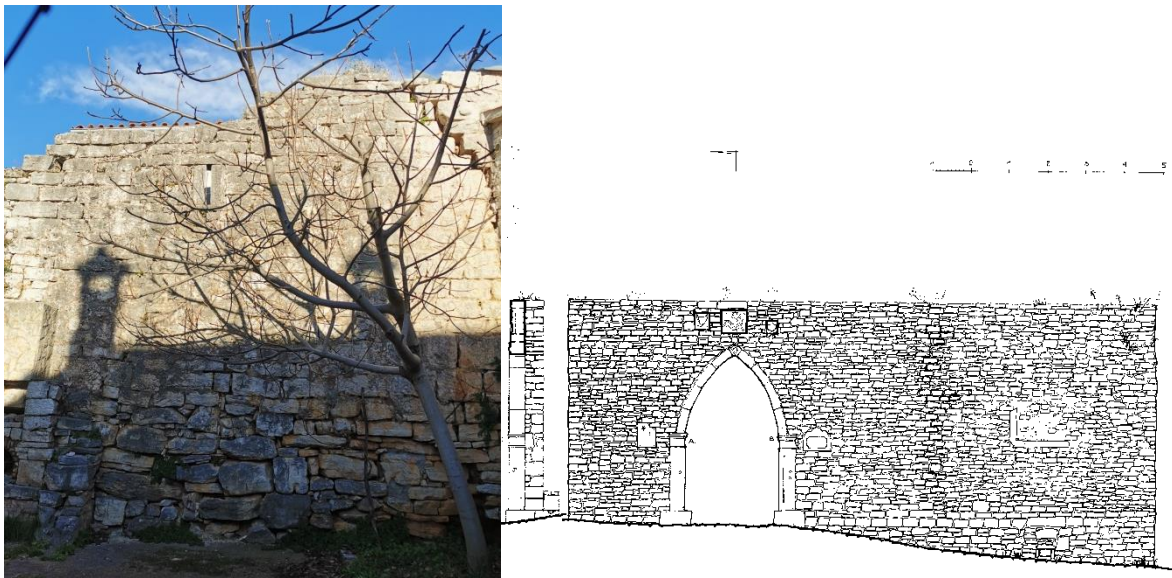
Slika 13. i 14. Pogled na zidine u dvorištu kuće na k.č. 465/1 na kojima je vidljiva strijelnica, snimila. Irena Radoslav 2021. i arhitektonska snimka Glavnih gradskih vrata autora: B. Bukowska, J. Szwalko (projekt dr. sc. Vladimira Bedenka)
