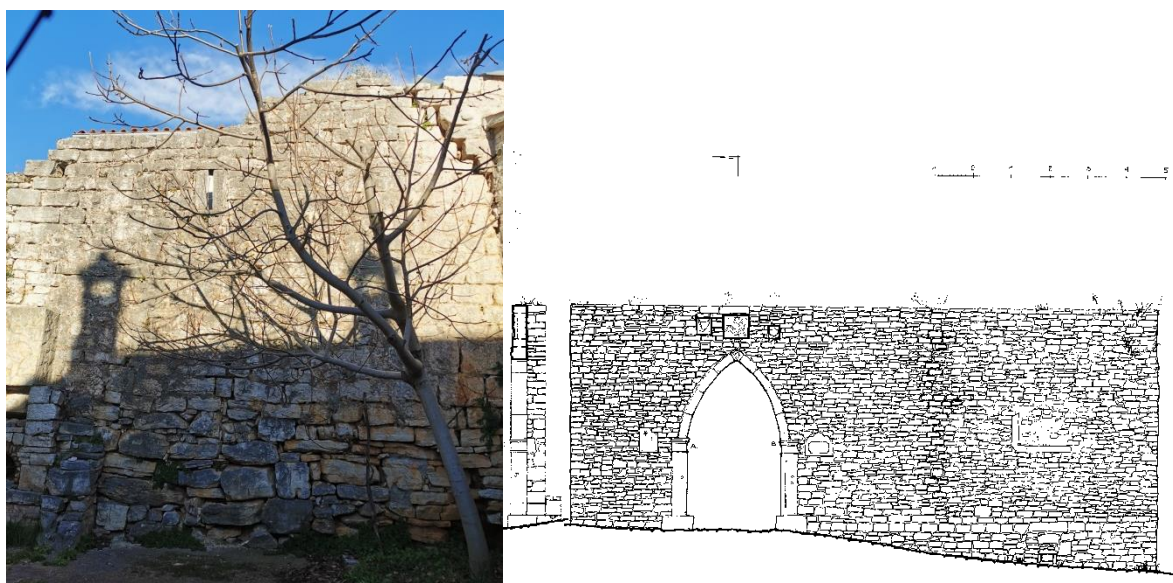
Slika 13. i 14. Pogled na zidine u dvorištu kuće na k.č. 465/1 na kojima je vidljiva strijelnica, snimila. Irena Radoslav 2021. i arhitektonska snimka Glavnih gradskih vrata autora: B. Bukowska, J. Szwalko (projekt dr. sc. Vladimira Bedenka)
