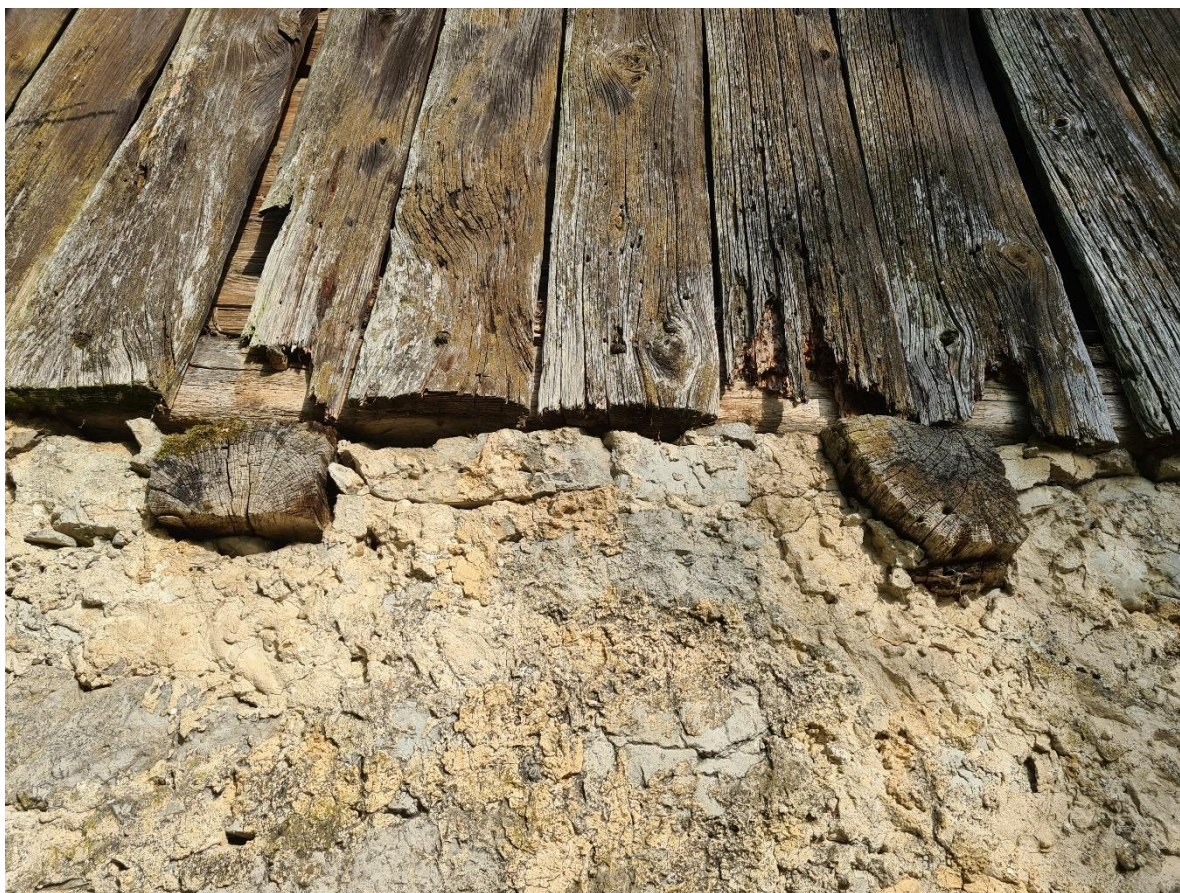
Slika 37. Spoj drvenog i kamenog materijala, stražnja strana šajara u Colnarima, detalj masivnih greda na kamenim temeljima (Foto: Katarina Tušek)
