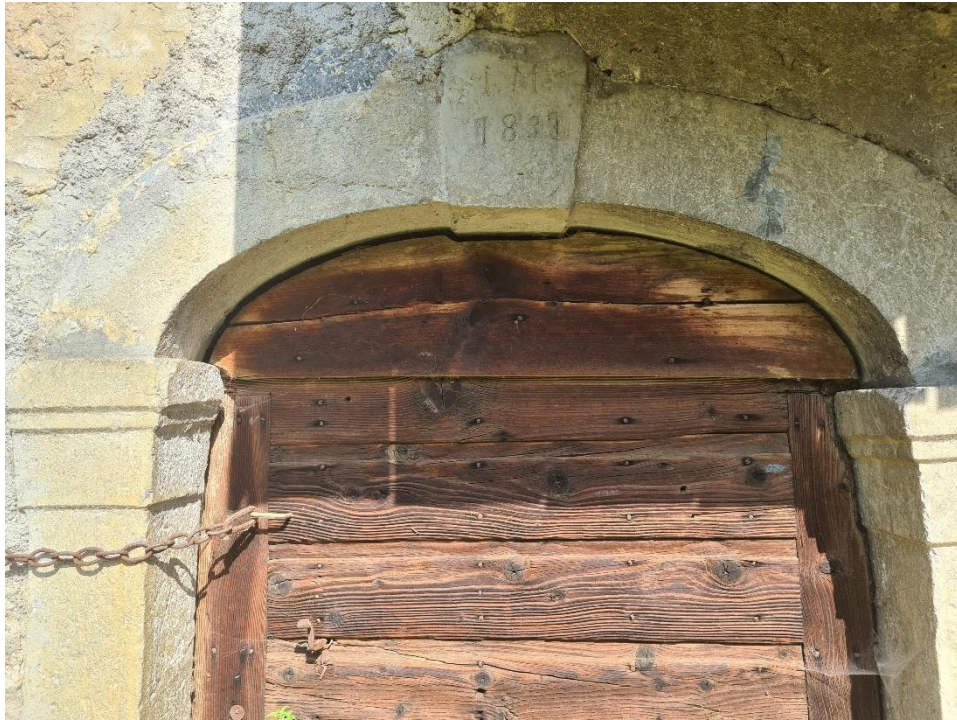
Slika 25. Vrata od kevra kuće u Smišljaku s isklesanom godinom gradnje i inicijalima vlasnika (Foto: Katarina Tušek)
