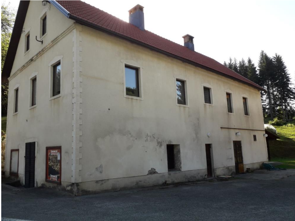
Slika 49. Građanska kuća u Donjoj Dobri, bočna strana (Foto: Katarina Tušek)
