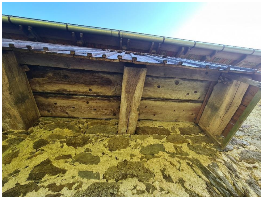
Slika 22. Nosive masivne drvene grede na kući u Smišljaku (Foto: Katarina Tušek)
