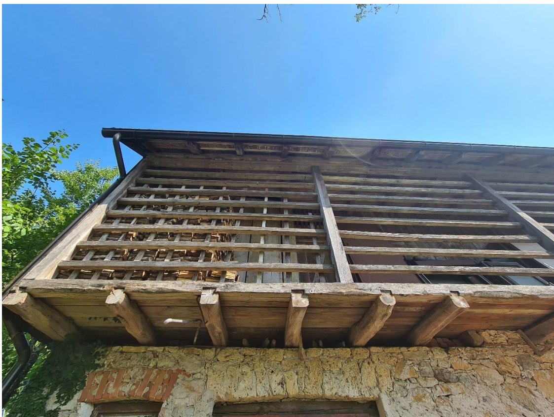
Slika 28. Detalj nosivih greda kozovca - Pr Zibarjevih u Dolušu (Foto: Katarina Tušek)
