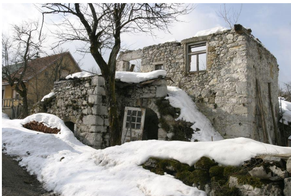
Slika 15. Ruševine Kuće Mance u Kutima (Foto: Damir Krizmanić)
