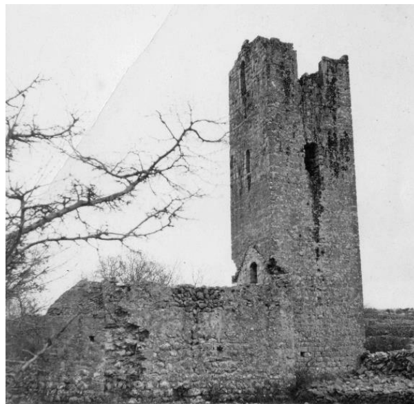
Slika 40. Crkve sv. Vida pokraj Dobrinja prije rekonstrukcijskih zahvata (foto: B. Pilar, 1931.; izvor: Fototeka Konzervatorskog odjela u Rijeci)
