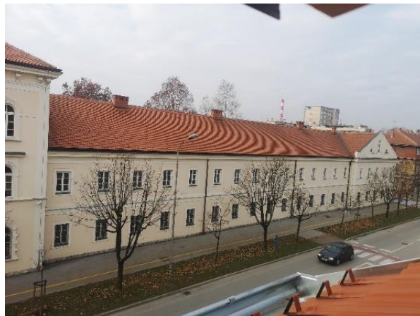
Slika 29. Domobranska vojarna, desno bočno izduženo krilo uličnog pročelja, današnje stanje
